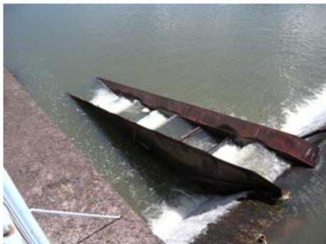
Captação - Escada de acesso de peixes
