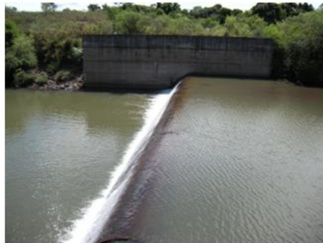
Captação - Trecho de desvio do Rio Pardinho
